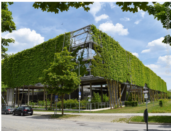
Abb. 2: Bodengebundener Bewuchs an Kletterhilfen (Swiss Re Bürogebäude in München)
