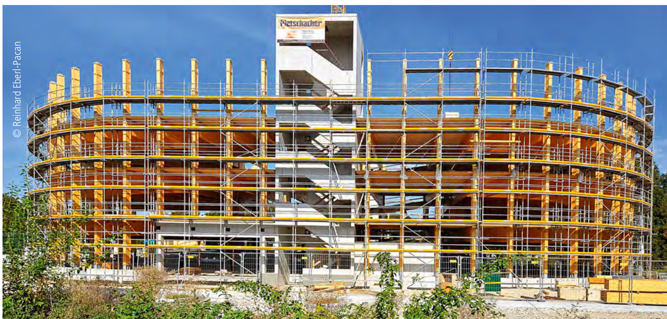
Abb. 2: Durch den hohen Vorfertigungsgrad der Bauteile konnte die Bauzeit auf 16 Wochen reduziert werden
